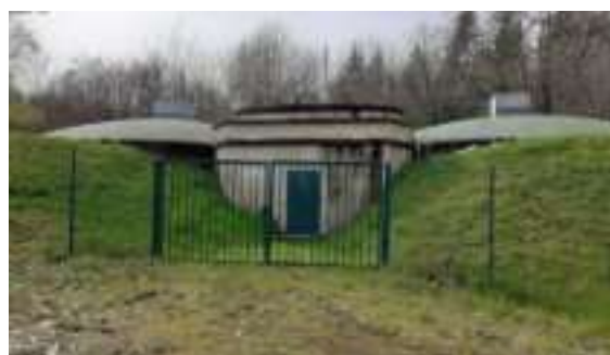
• les réservoirs du Mont Margueron à
