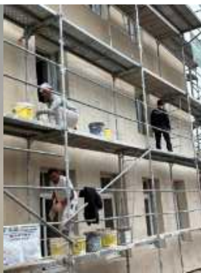
• Logements routes des combes
