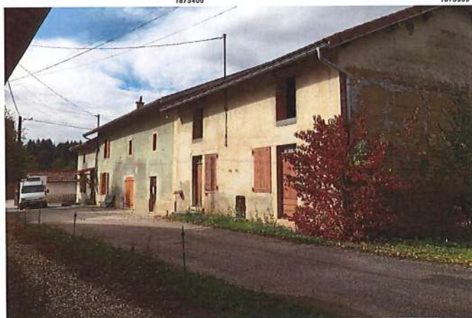
Bâtiment 7 à gauche et 8 ci-dessous
